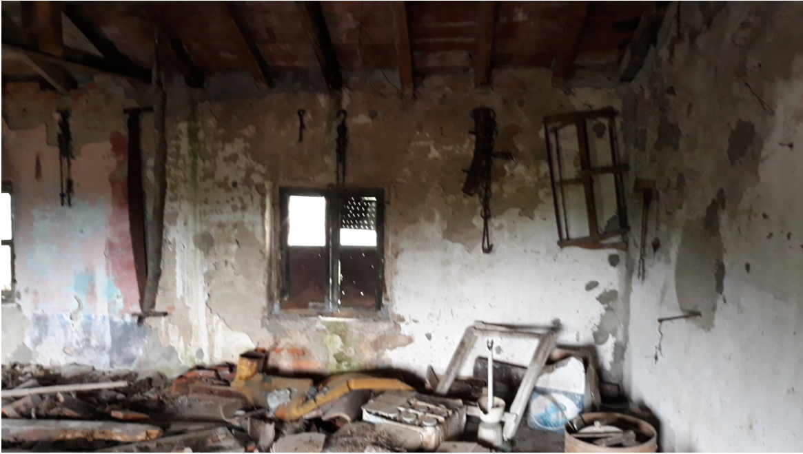
Veduta tettoia oggetto di demolizione per recupero indici FOTO N. 22
