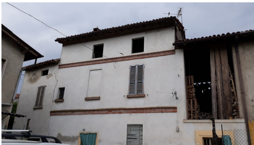
Veduta fabbricato dalla strada comune della corte FOTO N. 7
