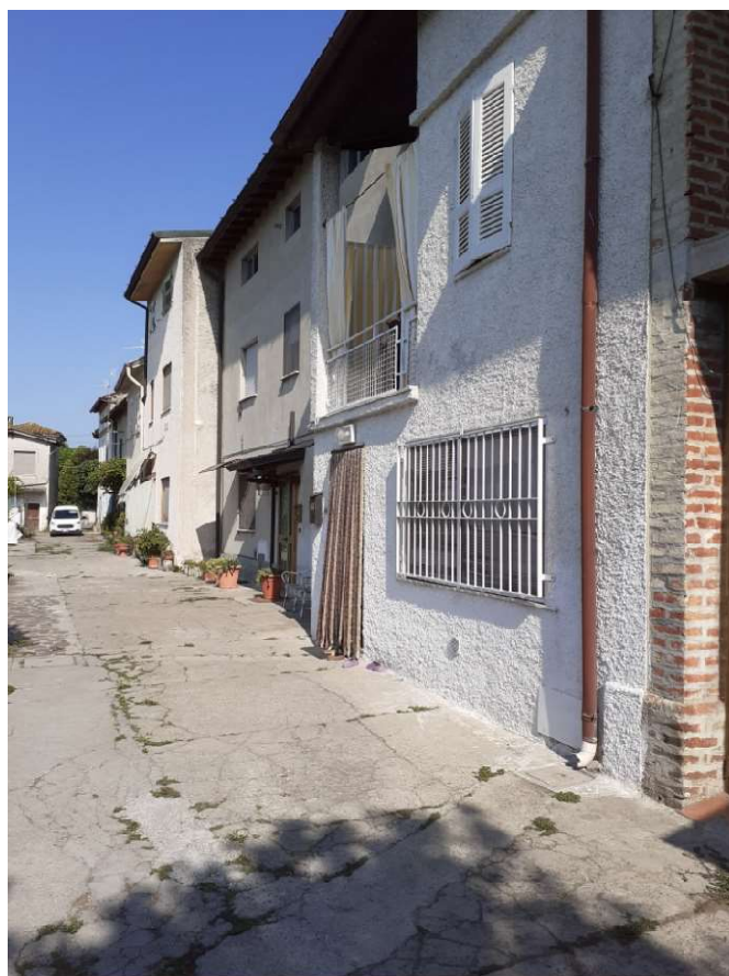
Veduta cortina dalla strada comune della corte FOTO N. 14
