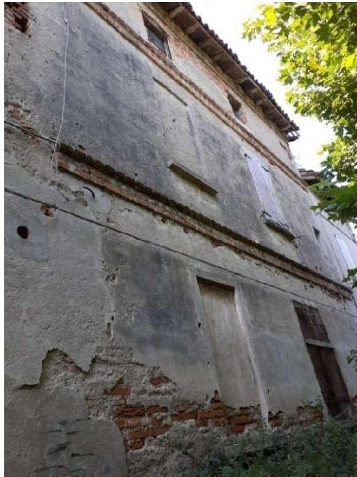
Veduta fabbricati FOTO N. 16
