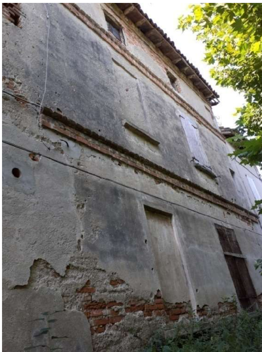
Veduta fabbricati FOTO N. 16
