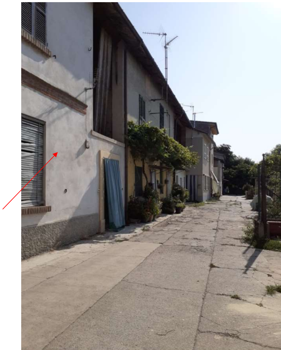
Veduta cortina dalla strada comune della corte FOTO N. 10
