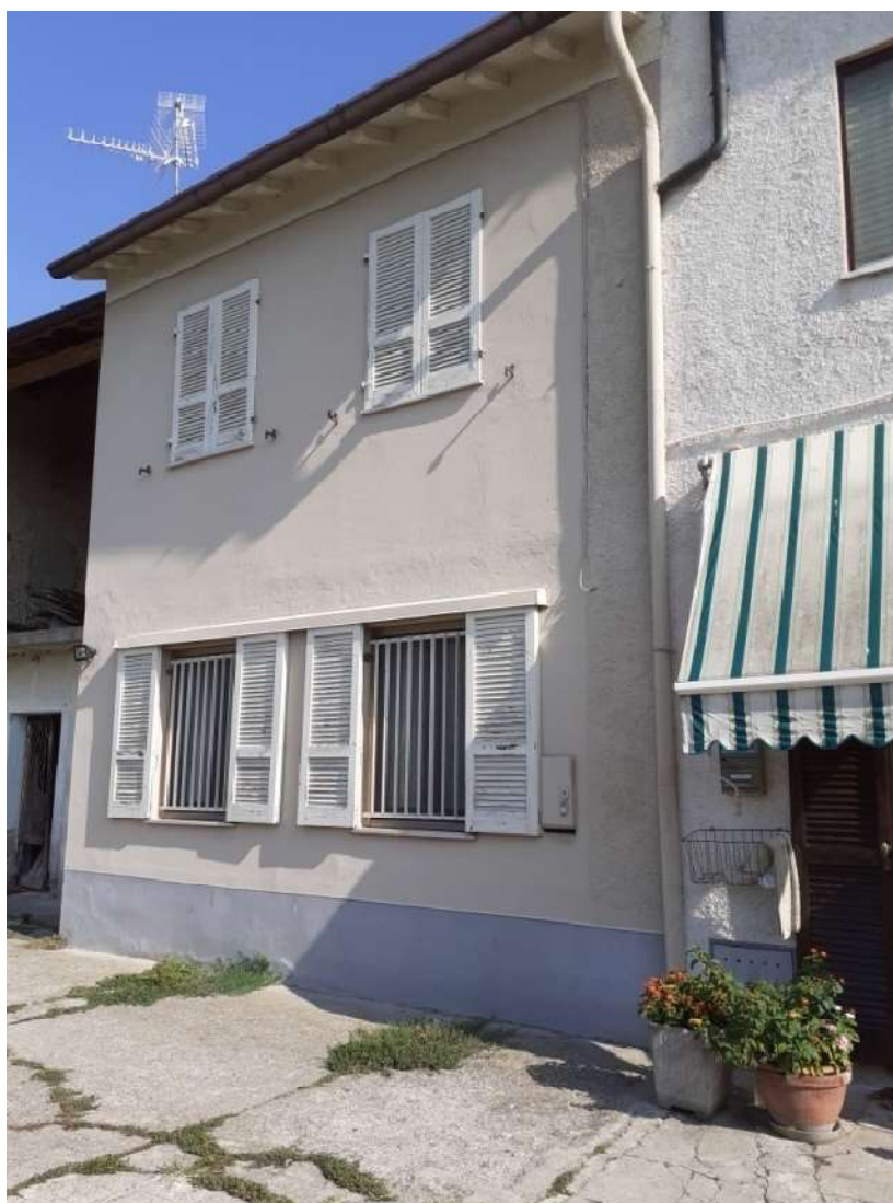
Veduta cortina dalla strada comune della corte FOTO N. 11
