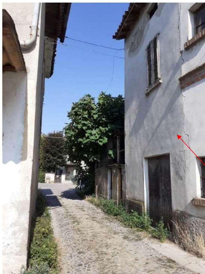
Veduta fabbricato dalla strada comune della corte FOTO N. 4
