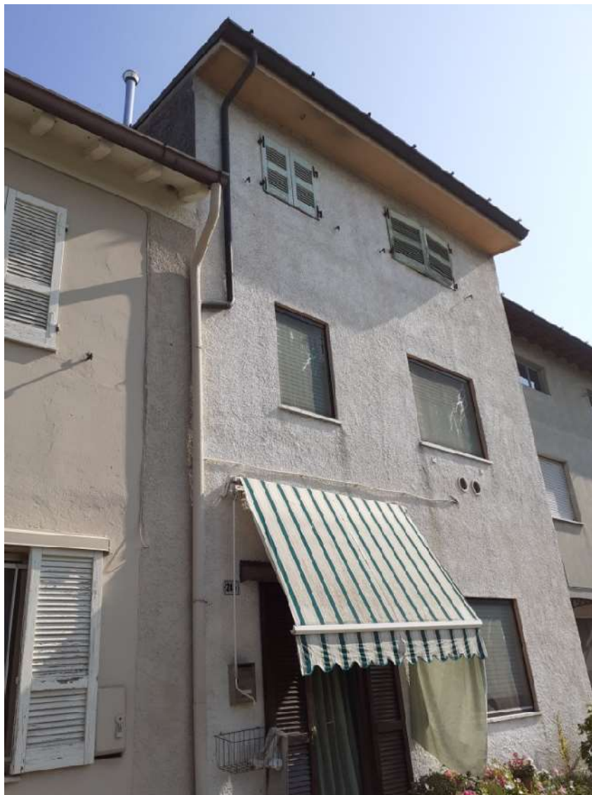
Veduta cortina dalla strada comune della corte FOTO N. 12
