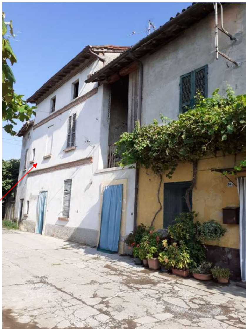
Veduta fabbricato dalla strada comune della corte FOTO N. 6
