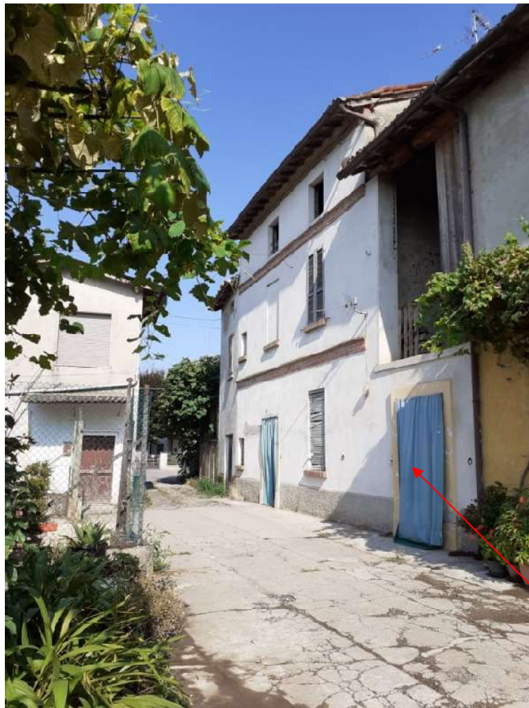
Veduta fabbricato dalla strada comune della corte FOTO N. 5
